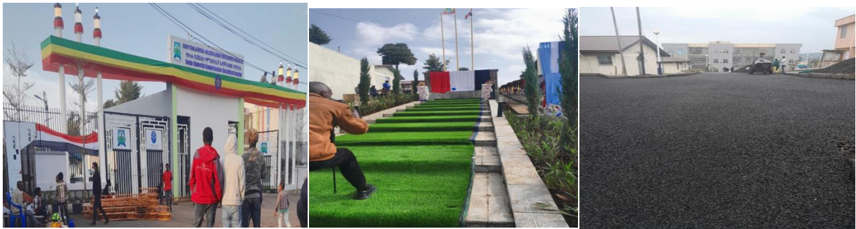
ምስል 10: ግንባታው የተጠናቀቀው የሆስፒታል መግቢያ በር
